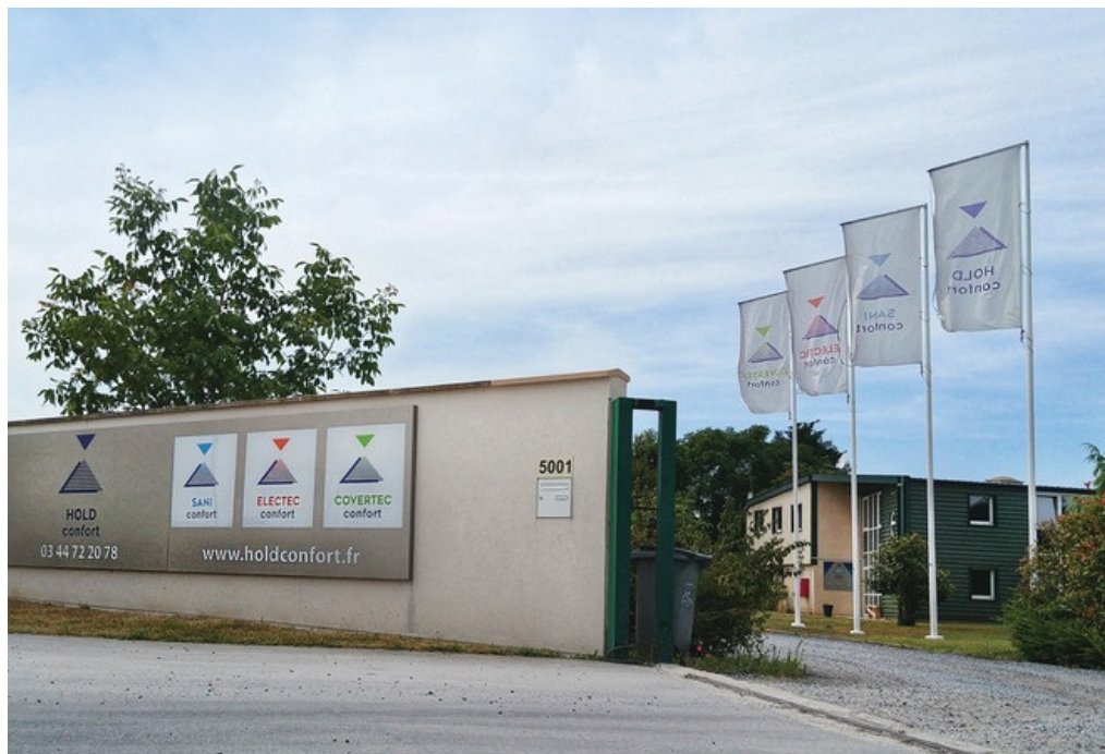
HOLD-CONFORT situé à Brenouille
